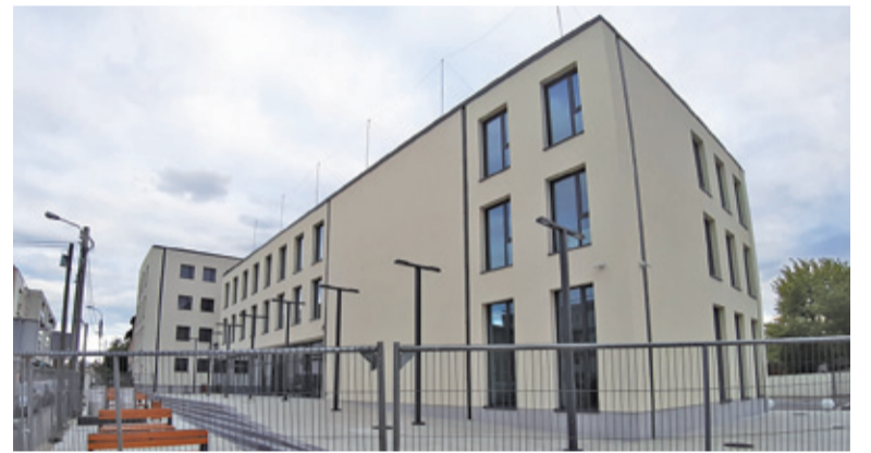
Nowy budynek czeka na pozwolenie na użytkowanie
