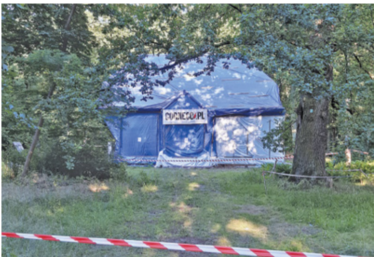
Obecnie budynek jest poddawany oddziaływaniu silnie trujących gazów, w celu pozbycia się szkodników z drewna
