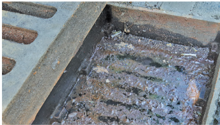
Tak wygląda wyczyszczony odpływ przy ul. Długiej w okolicach ul. Parkowej, gdzie zwykle tworzą się gigantyczne kałuże
