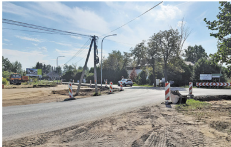
Prace budowlane trwają obecnie na terenie wykupionym przez Powiat pod budowę
