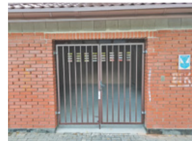
Gmina wyremontowała altanę śmietnikową, która splotęła w grudniu
