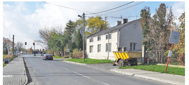
W ramach inwestycji m.in. zostanie przedłużony do ulicy Żytniej chodnik
