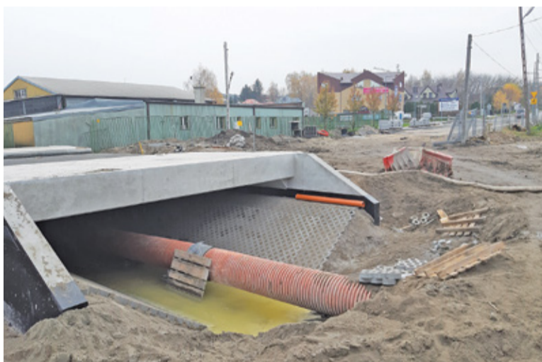
Zaawansowanie prac na dwa tygodnie przed terminem zakończenia budowy
