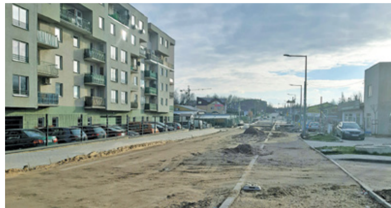
W poniedziałkowe południe na budowie ulicy nic się nie działo
