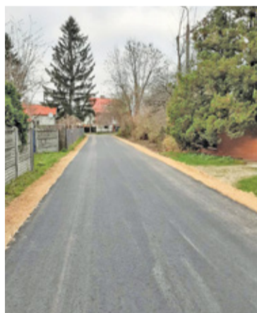
Ul. Żwirki i Wigury na osiedlu Parcela po przebudowie
