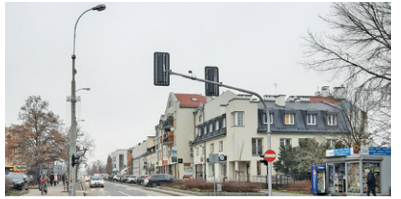
Procedura prowadzona przez konserwatora zabytków wstrzymała m.in. przebudowę ulicy Puławskiej
