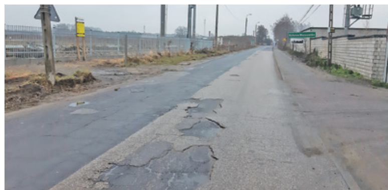
Nakładka asfaltowa na ostatnim odcinku przed skrzyżowaniem z Aleją Krakowską ma zostać wykonana na wiosnę
