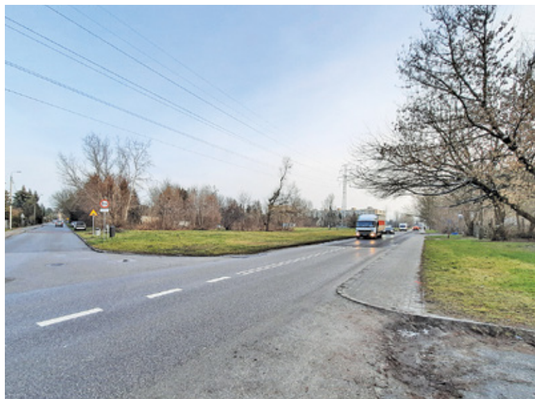
Ulica Energetyczna po przebudowie stanie się dwupasmowa
