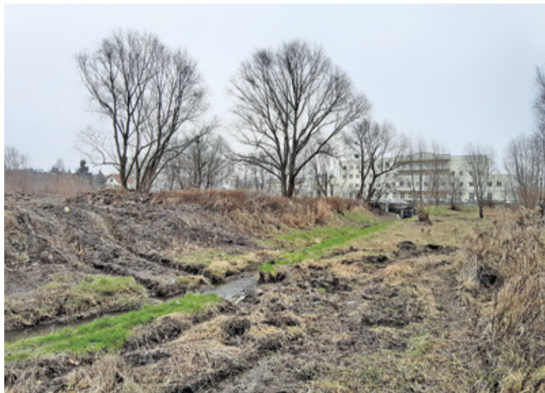
Przygotowany pod budowę teren pozwala zobaczyć, w którym miejscu pojawi się most i nowa droga
