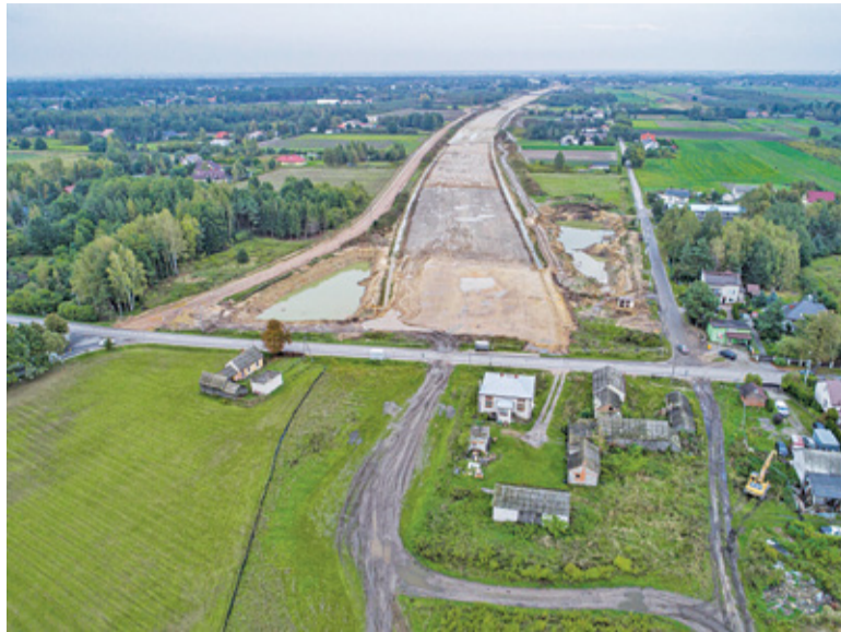
Jeśli nie będzie żadnych problemów z ofertami i odwołaniami, umowa na kontynuację prac budowlanych umowa z wykonawcą powinna zostać podpisana w maju br.
