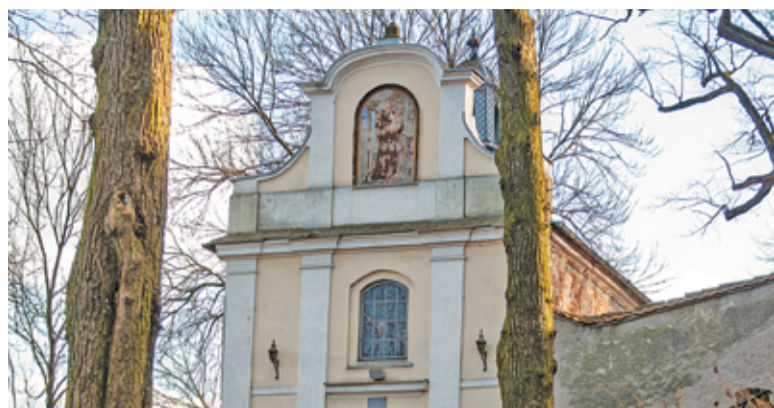
Pieniądże zostaną przeznaczone na zabezpieczenie fundamentów oraz remont dachu
