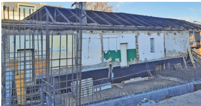
Dobudowane elementy, ale też spora część dachu, zostały już rozebrane. W ubiegłym tygodniu były wylane fundamenty pod nową część budynku
