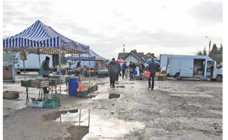
Po modernizacji nawierzchnia targowiska ma być w końcu przyjazna dla handlarzy i klientów
