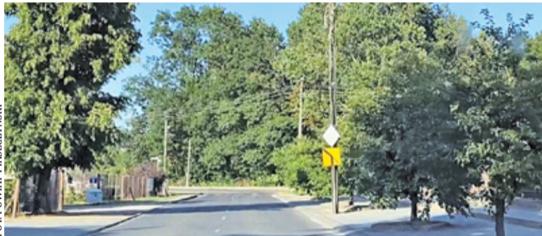
Prace w tym miejscu mają potrwać do końca czerwca
