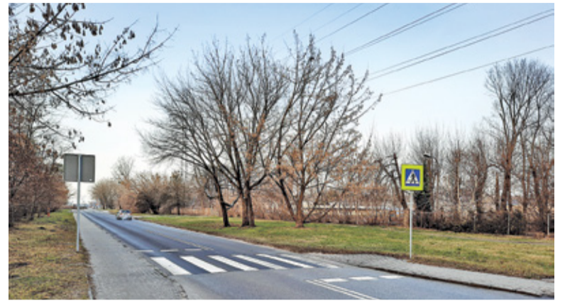
Ulica Energetyczna ma być dwupasmowa również po drugiej stronie ronda przy centrum handlowym
