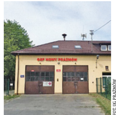
Pozyskane środki pomogą zmodernizować strażnicę OSP w Nowym Prażmowie
