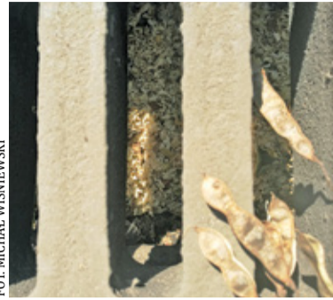
Wiele studzienek wciąż jest zasypanych piachem, liśćmi i igliwem
