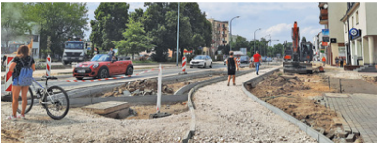
Obecnie trwają prace przy budowie części pieszo-rowerowej
