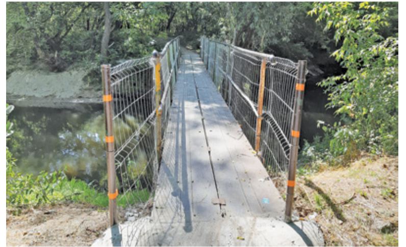
Most miałby powstać w miejscu istniejącej, tymczasowej przeprawy
