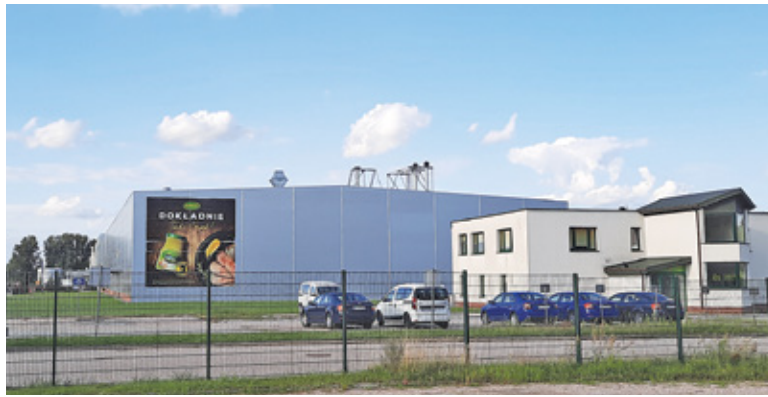
Firma planuje w jednej z hal magazynowych uruchomić linię produkcyjną
