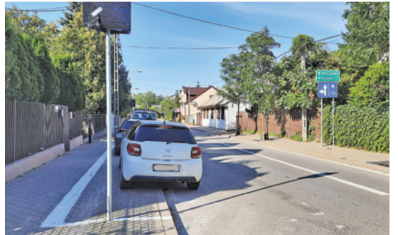
Przesunięcie miejsc parkingowych na chodnik rozwiązało problem zbyt wąskiego pasa ruchu na ul. Kilińskiego
