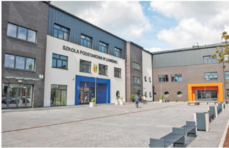
Budowa nowej szkoły kosztowała samorząd ponad 38 mln zł
