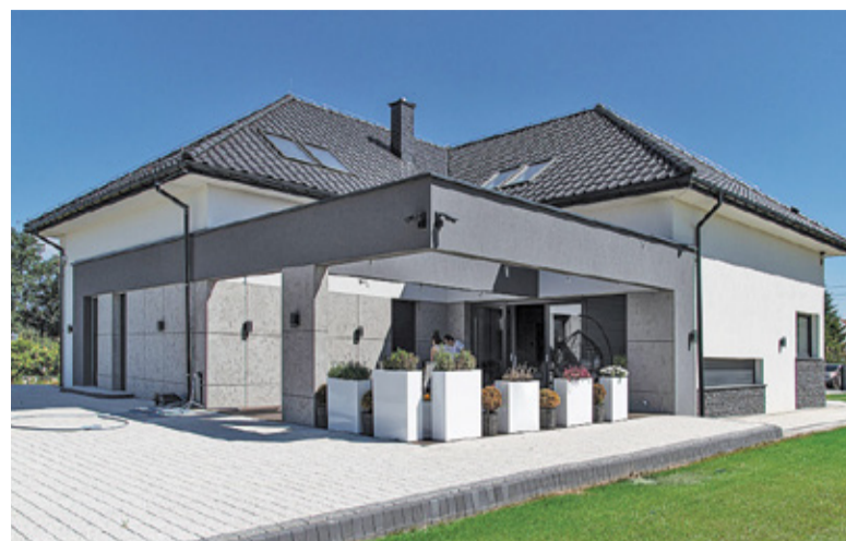
Efekt betonu uzyskany dzięki zastosowaniu tynku modelowanego Baumit CreativTop
