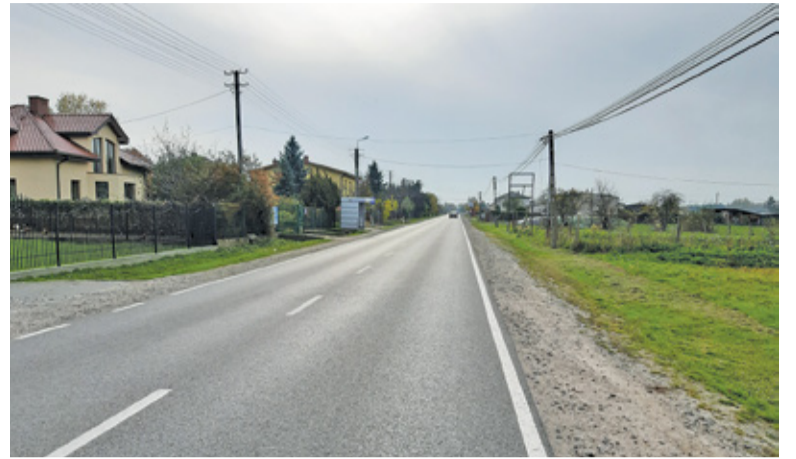
W okolicach przystanku powstanie bezpieczne przejście dla pieszych
