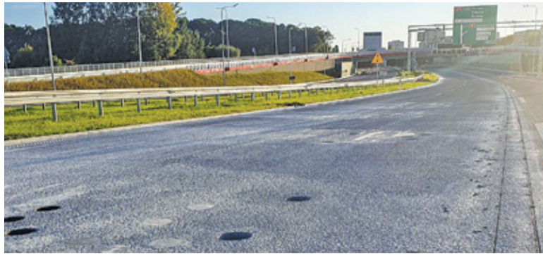
Próbki nawierzchni pokazały, że nie jest ona wystarczająco odporna na działanie środków odładzających
