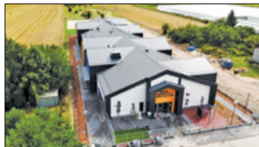
|| Lesznowola – Budowa XXI wieku s. 4
