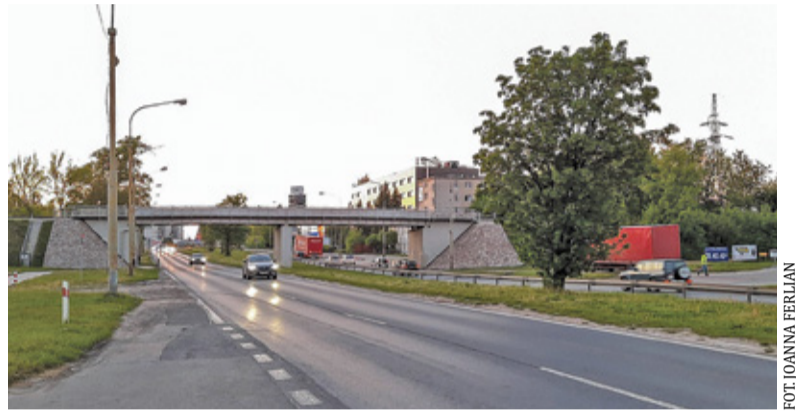
W pierwszej kolejności prace mają być realizowane na nitce prowadzącej do Piaseczna
