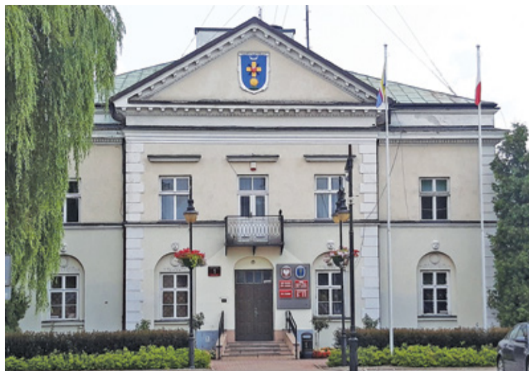
W ramach zadania zostaną wymienione okna oraz drzwi balkonowe. Wykonawca podda również renowacji witraże
