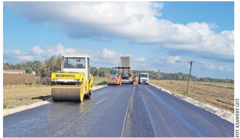
Mieszkańców cieszy nowa nawierzchnia, choć skarżą się na uciążliwość prac
