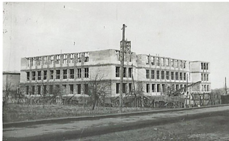
Budowa nowej szkoły przy ul. Chyliczkowskiej, II połowa lat 50.
