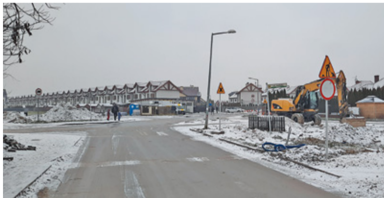
Prace budowlane zostały przerwane, a przez skrzyżowanie można jeździć
