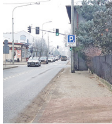
Miejscami zabudowa znajduje się bardzo blisko jezdni, co komplikuje przebudowę drogi
