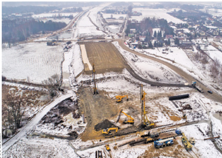
Prace na piaseczyńskim odcinku trasy S7 są realizowane mimo zimowej aury
