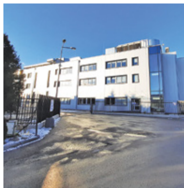
Inspektorzy WIOŚ prowadzili czynności kontrolne również na terenie fabryki
