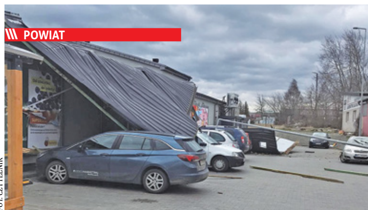
Zerwany dach warsztatu samochodowego spadł na market przy ul. Dworcowej
