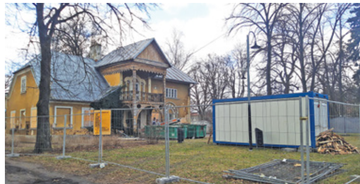
Na razie wykonawca prowadzi prace wewnątrz budynku
