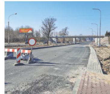
Na nowej jezdni pozostało wykonanie ostatniej warstwy nawierzchni oraz oznakowania
