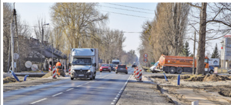
Na razie realizowane są prace na poboczach drogi
