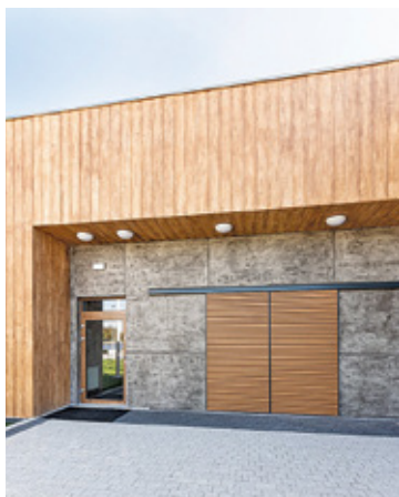
Nowoczesne tynki oferują szerokie możliwości w zakresie kształtowania wyglądu elewacji i bez trudu imitują inne materiały jak np. beton czy drewno
