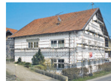
Montaż płyt styropianowych przy pomocy tradycyjnych łączników mechanicznych
