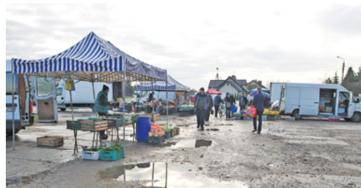
Obecny plac targowy wymaga przede wszystkim odwodnienia i utwardzenia nawierzchni
