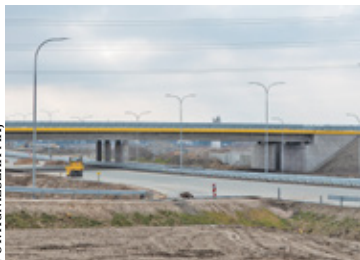
Lesznowski odcinek drogi jest już w znacznym stopniu gotowy do jazdy
