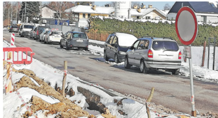
Tymczasowy parking na remontowanej obecnie ulicy Geodetów
