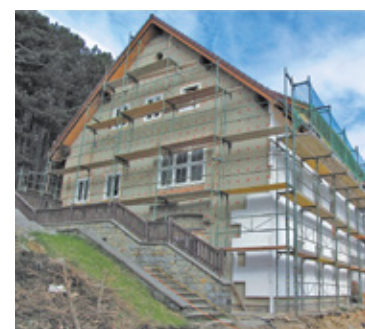
Montaż płyt styropianowych przy pomocy innowacyjnych kotew Baumit StarTrack
