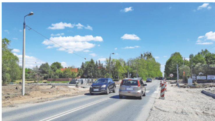
Ruch wahadłowy w Żabieńcu został zniesiony, ale utrudnienia czekają nas jeszcze pod koniec przebudowy
