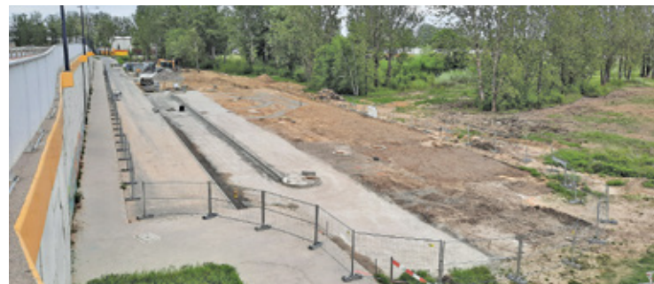
P&R Jeziorki powstaje przy południowo-wschodniej części wiaduktu
