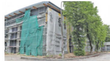
Na budowie hali były nawet kilkumiesięczne przeestoje
