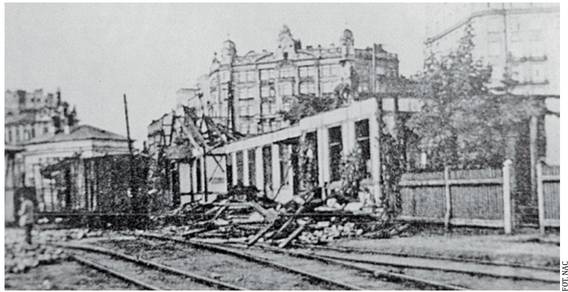
Rozbiórka stacji kolejki grójeckiej na pl. Unii Lubelskiej
