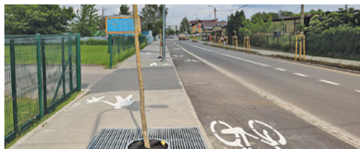
Na ul. Nadarzyńskiej od strony targowiska miejskiego prace zasadnicze dobiegły końca
