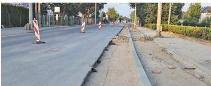
Na ul. Chyliczkowskiej prace potrwać jeszcze ok. 6 tygodni
