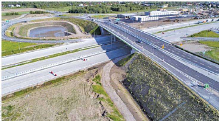
Budowa trasy S7. Odcinek Lesznowola – Warszawa Okęcie
