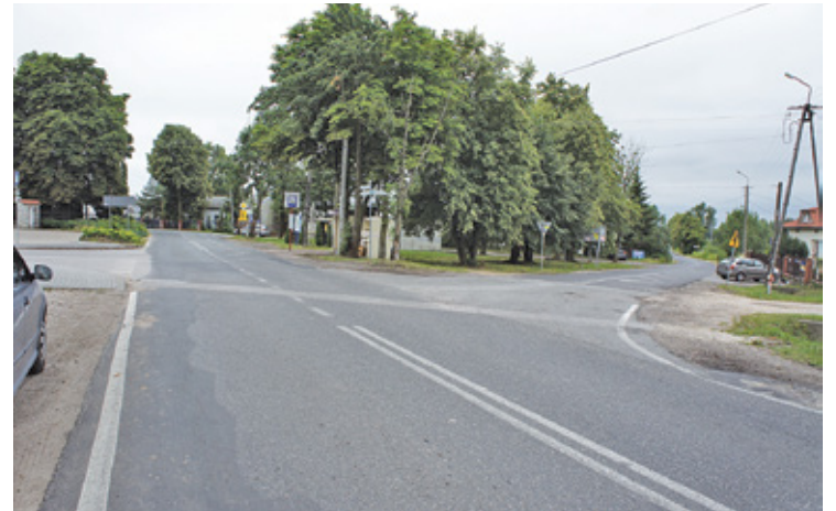
Obecnie na drodze wojewódzkiej 683 nie ma nawet chodnika i często dochodzi do niebezpiecznych sytuacji
