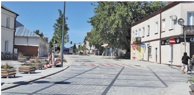
Na ul. Chyliczkowskiej wciąż pracuje ciężki sprzęt budowlany
