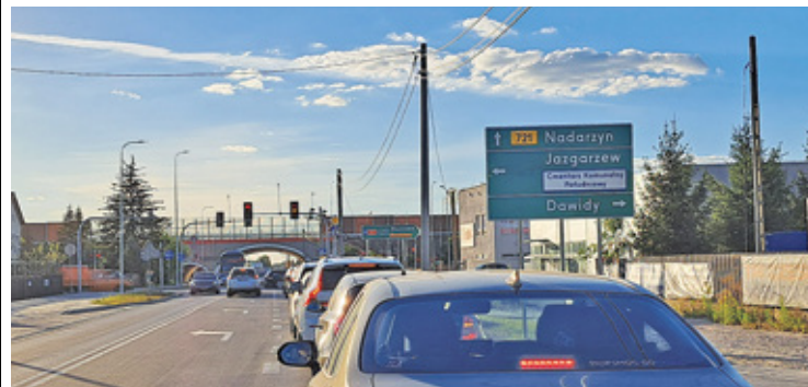
Budowa nowej, dwupasmowej obwodnicy Lesznówoli odciąży wiecznie zakorkowaną ulicę Stoneczną
