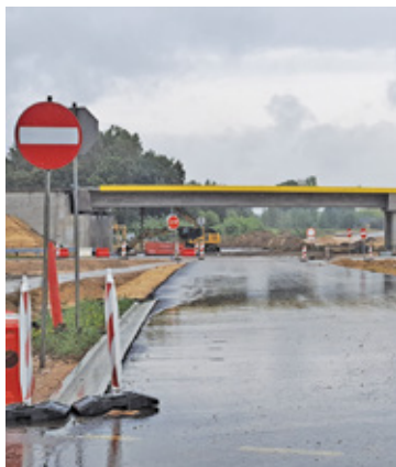
Zadaniem wykonawcy jest m.in. budowa 11 wiaduktów i 6 mostów
