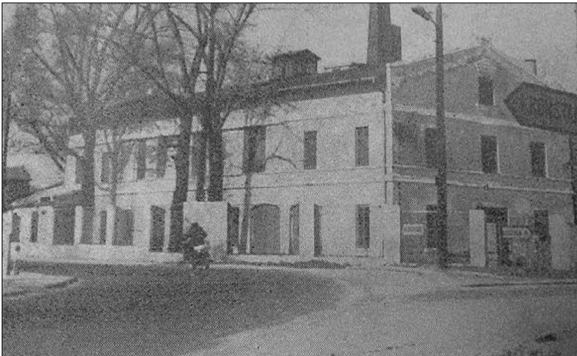
Skrzyżowanie w robotniczej Jeziornie z drogowym wskazującym dojazd do Konstancina.
