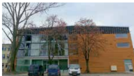
Sala gimnastyczna w ZSZ im. ppor. Gierczaka
