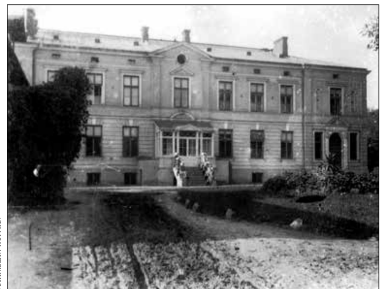
Gmach główny szkoły, tzw. Pałac i nieistniejąca już szklana werandka, rok 1921, źródło archiwum Stanisława Hofmana
