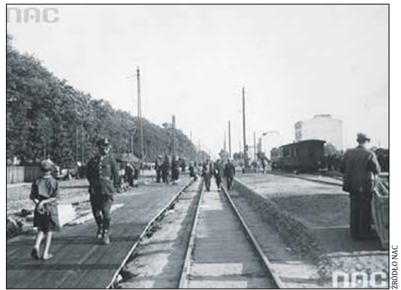
Prowizoryczna stacja, przeniesiona z pl. Unii Lubelskiej na skrzyżowanie ul. Puławskiej z ul. Odyńca, rok 1935
