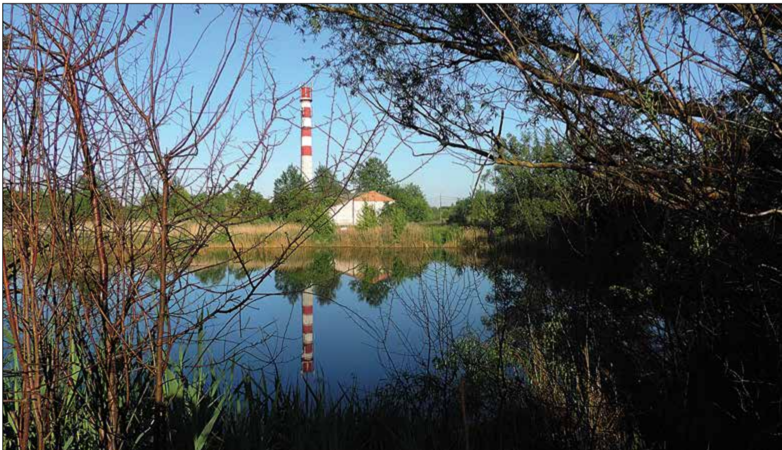
Piaseczno-Gołków, widok na komin i ruiny cegielni
