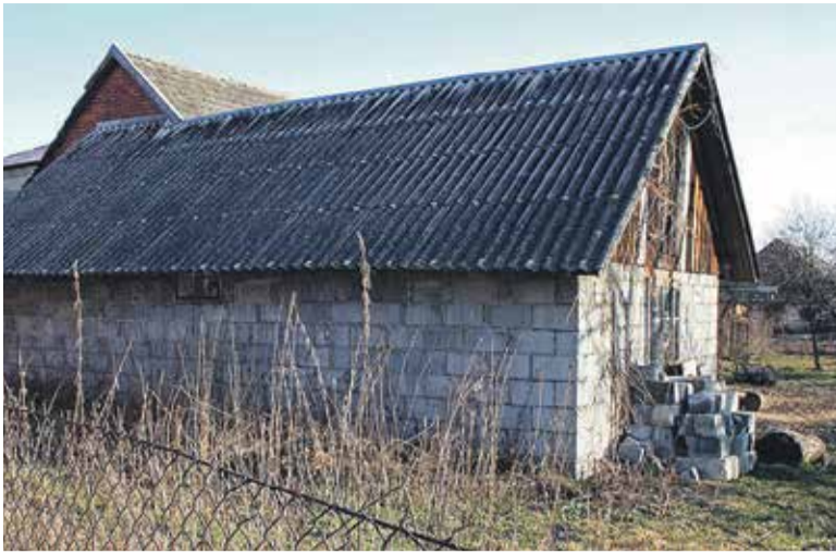
Dach pokryty eternitem
