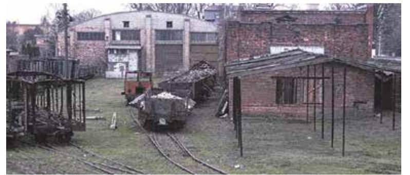
Miejsce po spalonej hali lokomotywowni oraz ceglany budynek kuźni
